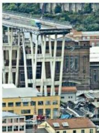
Genova. Il moncone del ponte Morandi dopo il crollo
